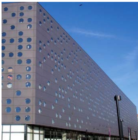
Politechnika Wroclawska – budynek z salami Studium Kształcenia Podstawowego
